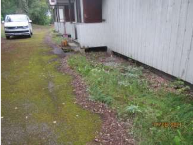
Kuva 45. Maan pinnan kallistukset ovat paikoin melko huonot.
