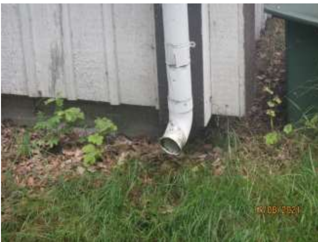
Kuvat 15-16. Kattovedet johdetaan suoraan maahan, ja syöksyputki on irronnut pohjoiskulmassa.
