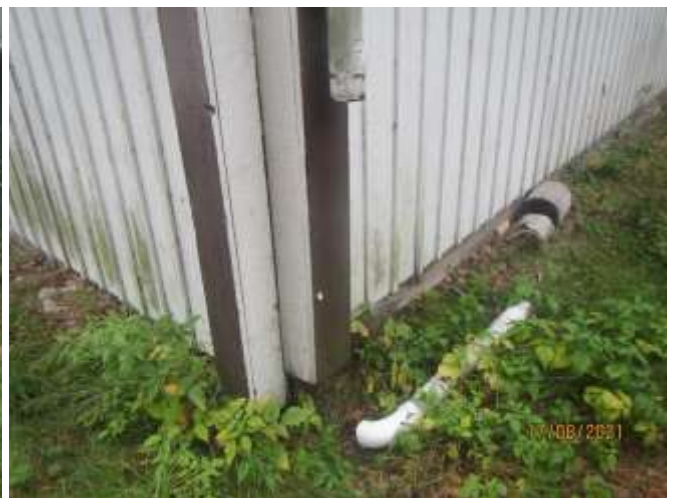
Kuvat 15-16. Kattovedet johdetaan suoraan maahan, ja syöksyputki on irronnut pohjoiskulmassa.
