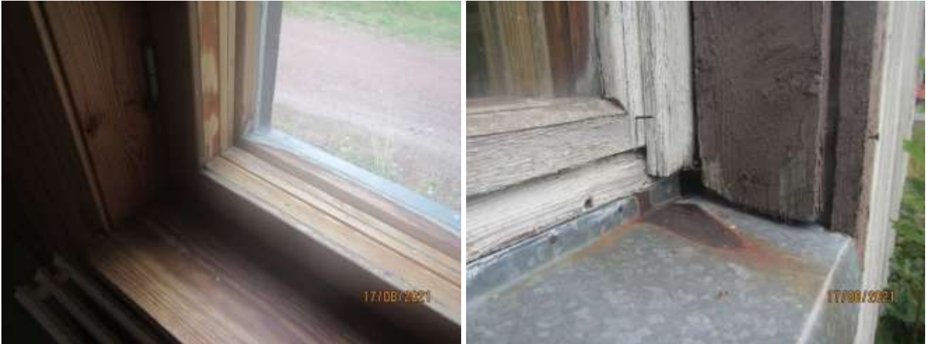
Kuvat 33-34. Yleiskuva ikkunoista.
