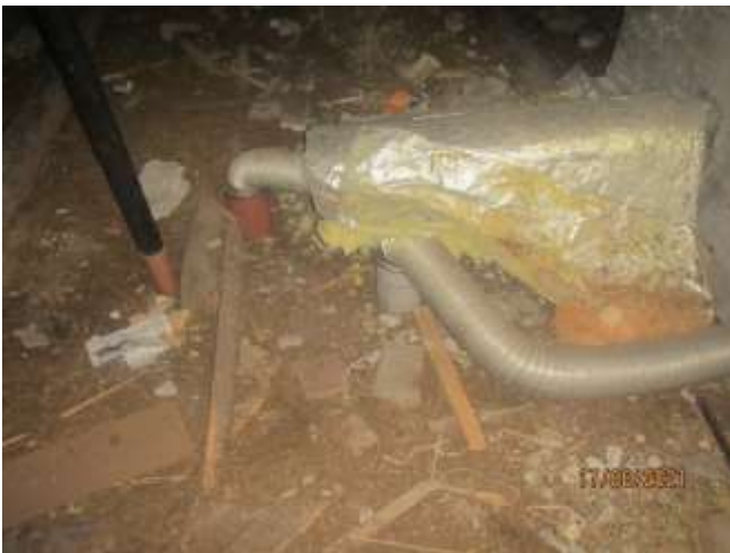
Kuvat 29-30. Poistoilmaputket kylmällä ullakolla.
