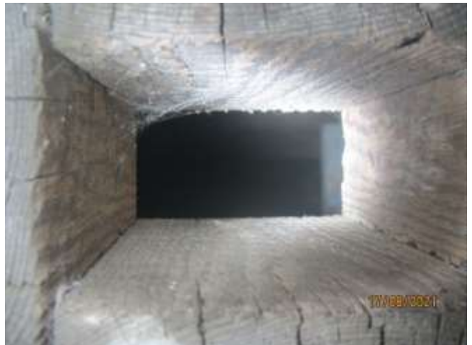
Kuvat 3-4. Puurakenteinen alapohjarakenne pannuhuoneessa sekä tuuletusaukko sokkelissa.
