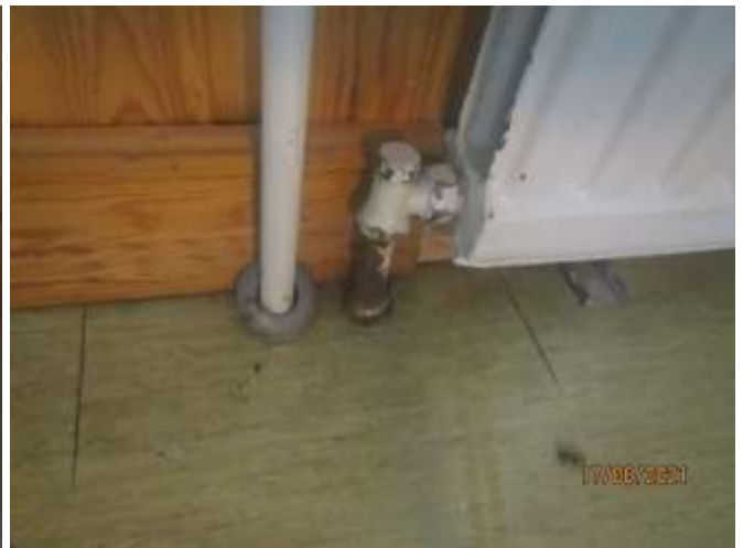
Lämpöjohtoissa on paikoin pintaruostetta.
