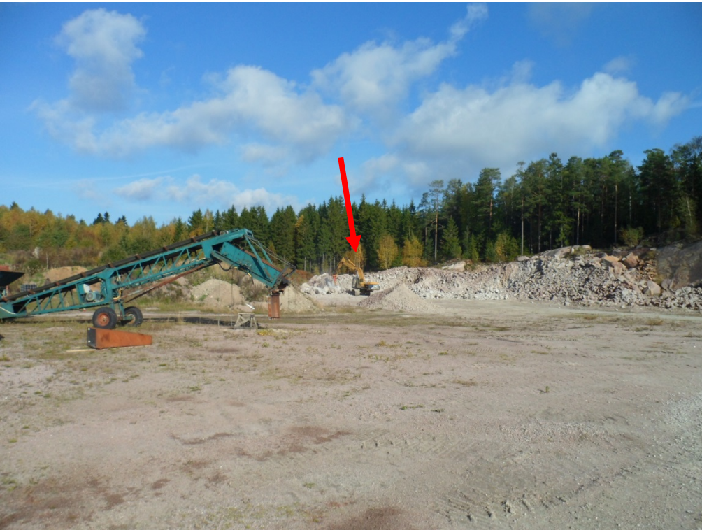
Kuva 3. Rikotus (kaivinkone), kuva pohjoiseen päin.
