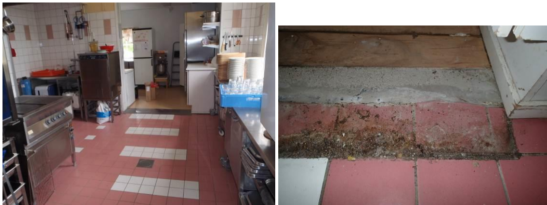
Kuvat 5 ja 6. Keittiön kynnyksellä on kertynyt runsaasti likaa ja kosteutta.
