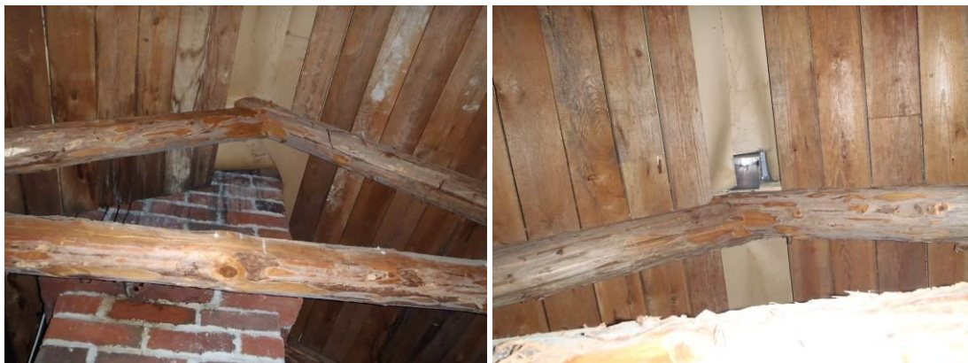
Kuvat 12 ja 13. Vesikaton aluslaudoissa ja aluskatteessa oli kosteusjälkiä piipun sekä harjan tuuletusputkien ympärillä.
