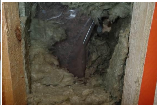
Kuvat 10 ja 11. Kirjaston ulkoseinä on levytetty luonnonkivisokkella vasten. Alaosassa on harkkomuurauksen takaa virtasi maakellarinhajuista ilmaa. Seinän yläosassa luonnonkivisokkelin pinnassa on muovi rakenteen ulko-osissa.
