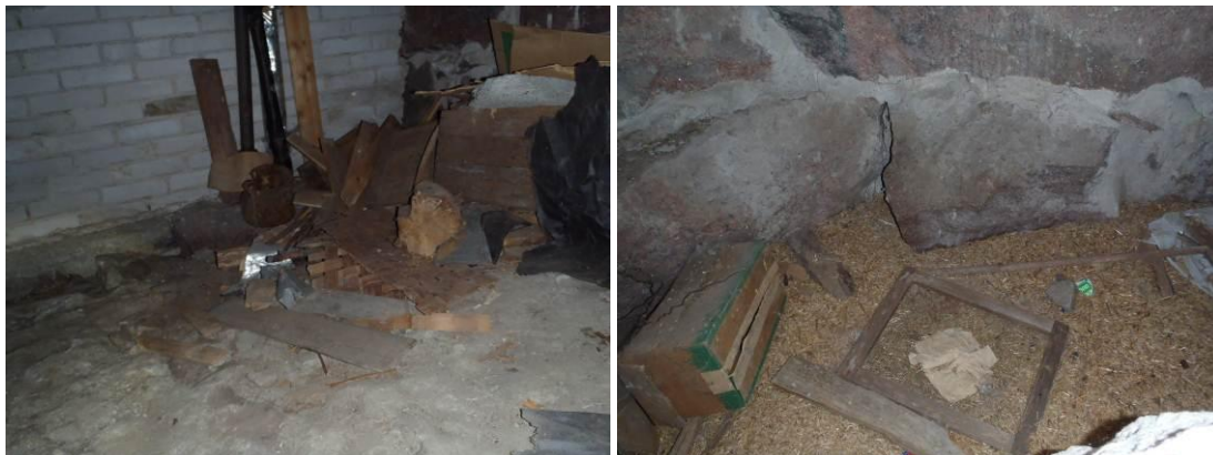
Kuvat 1 ja 2. Ryömintätilan pohjalla on runsaasti orgaanista materiaalia.
