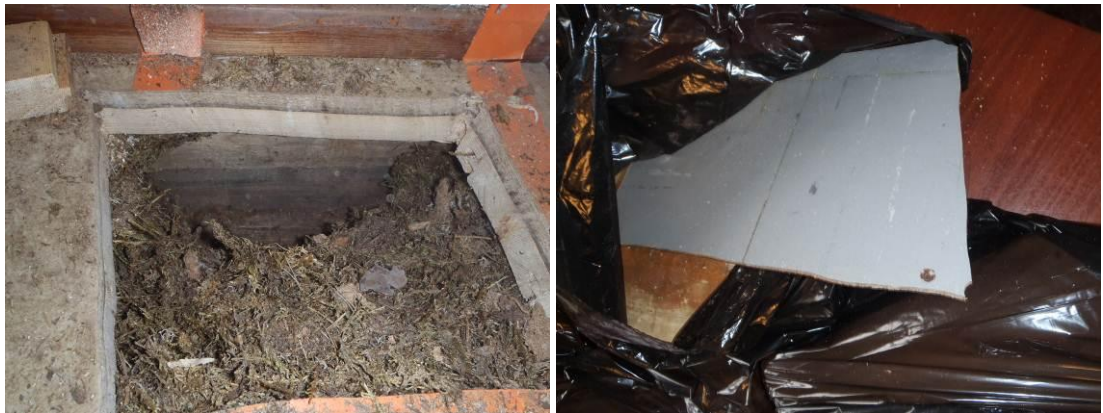
Kuvat 12 ja 13. Keittiön (taukotila) lattiassa oli harmaata vinyylilaattaa lastulevykerroksen alla.
