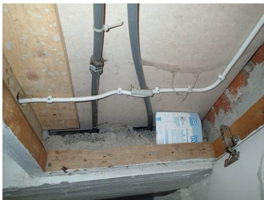
Kuvat 10 ja 11. Kirjaston ulkoseinä on levytetty luonnonkivisokkella vasten. Alaosassa on harkkomuurauksen takaa virtasi maakellarinhajuista ilmaa. Seinän yläosassa luonnonkivisokkelin pinnassa on muovi rakenteen ulko-osissa.
