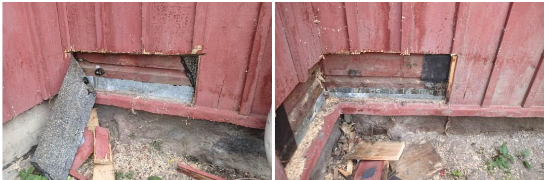
Kuvat 17 ja 18. Ulkoverhouksen alla on pääosin joko sirotepintainen tervapahvi tai si- leä tervapahvi. Ulkoverhouksen takana on vanha vaakaverhous.
