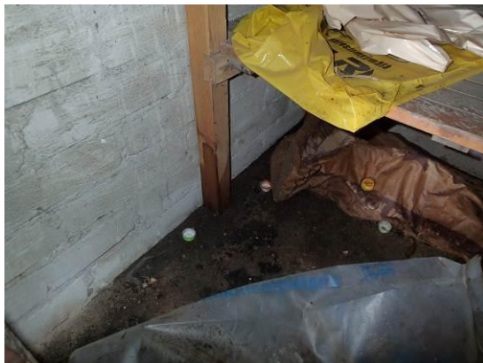
Kuvat 6 ja 7. Lounaispäädyn varastotilan lattialla oli vettä.
