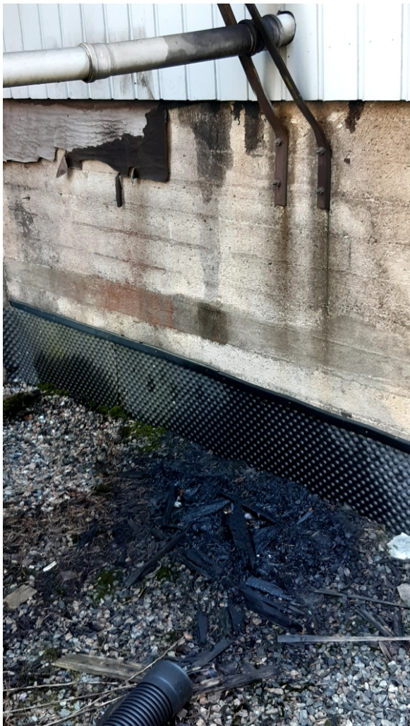
Den huvudsakliga orsaken till utsläppet var antagligen cisternens påfyllningsrör. Päästön pääasiallinen syy oli todennäköisesti jäteöljsäiliön täyttöputki.
