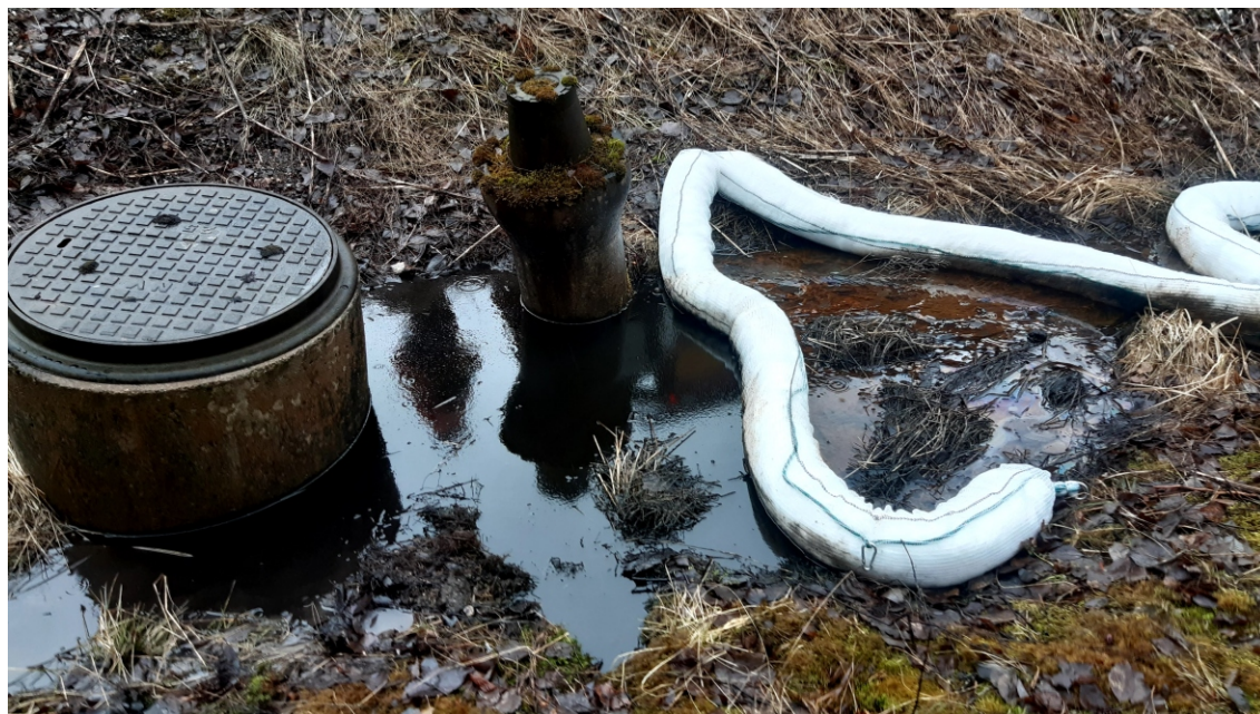
Det öppna diket vid Industrigatan efter regn. Teollisuuskadun tieoja sateen jälkeen.
