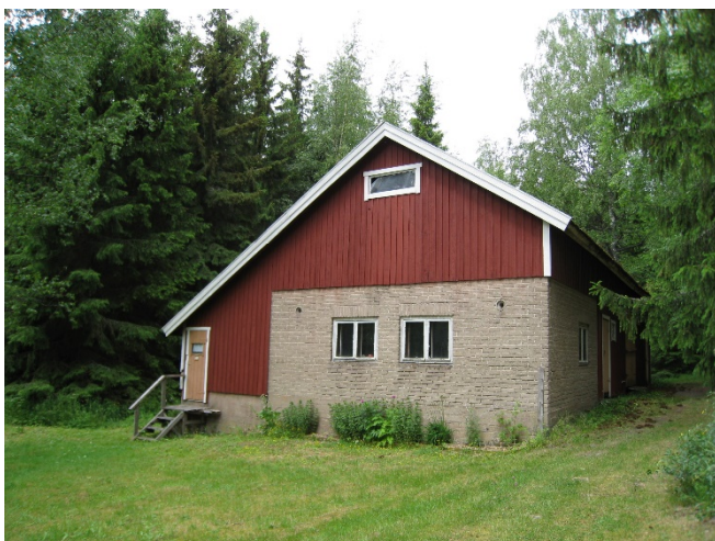
Ekonomibyggnaden på bostadsfastigheten. Asuintilan talousrakennus
