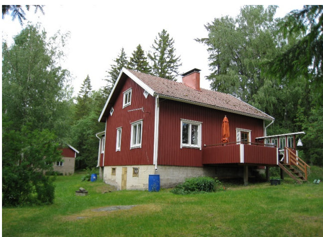
Huvudbyggnaden på bostadsfastigheten i planområdet från året 1947 Kaava-alueella olevan asuintilan päärakennus vuodelta 1947
