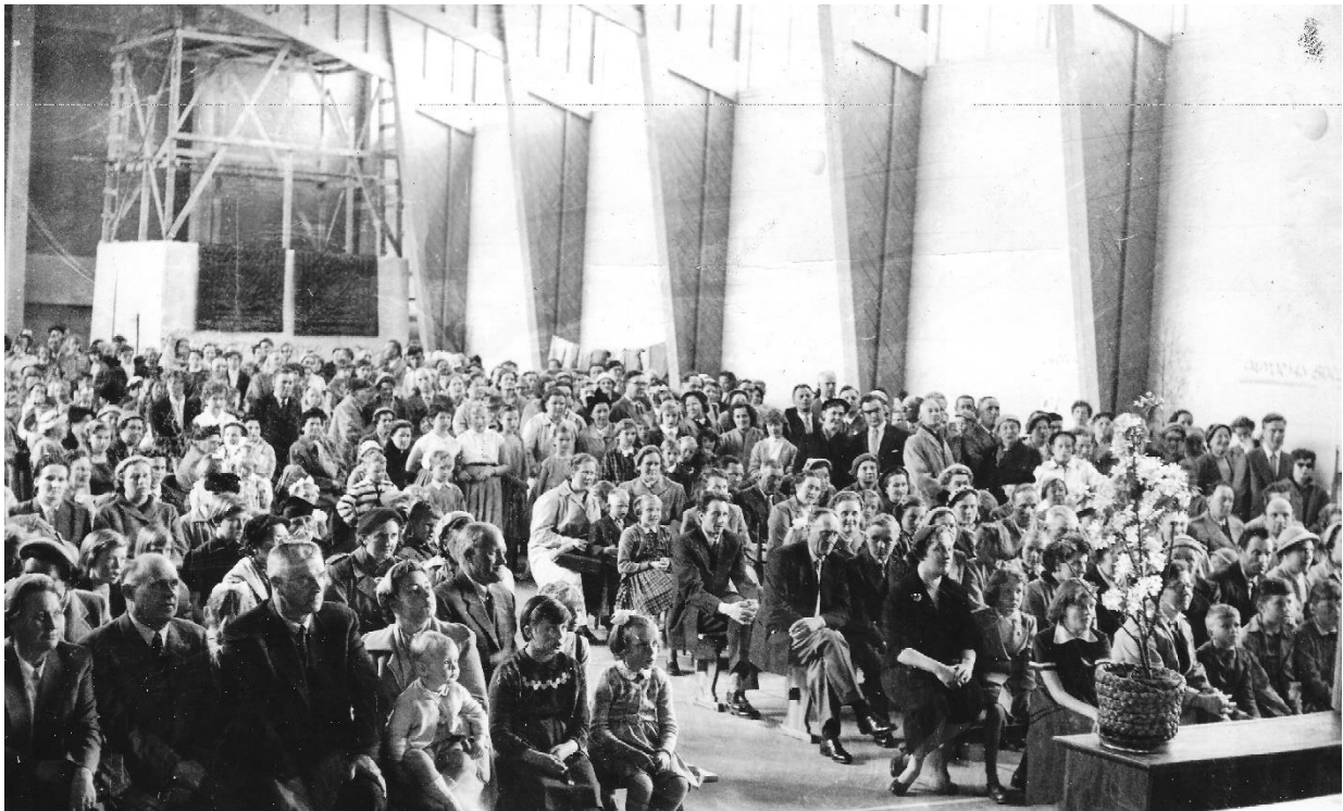
YHTEISKOULUN RAKENNUSVAIHEESSA OLEVASSA VOIMISTELUSALISSA JÄRJESTETTY VARAINKERUU-BASAARI VUONNA 1956. YHTEISKOULUN ARKISTO.
