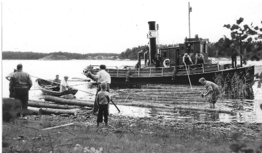
TUKKIPUUTA TOIMITETTIIN RAKENNUSTYÖPAIKALLE LAUTTAMALLA KIRKKOSALMEN HALKI TAI KUORMA-AUTOILLA. YHTEISKOULUN ARKISTO.
