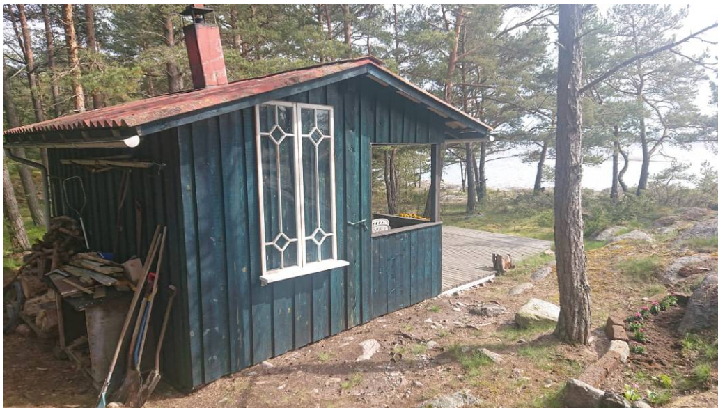
Bild 10. Bastu som är byggd på 1970-talet.
