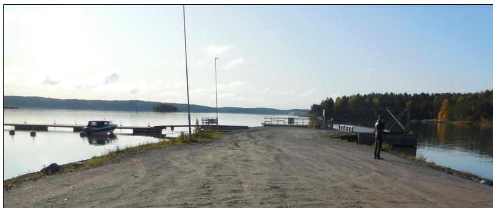
Bild 9. Bryggkonstruktionerna på jordvallen i södra delen av båthamnen.
