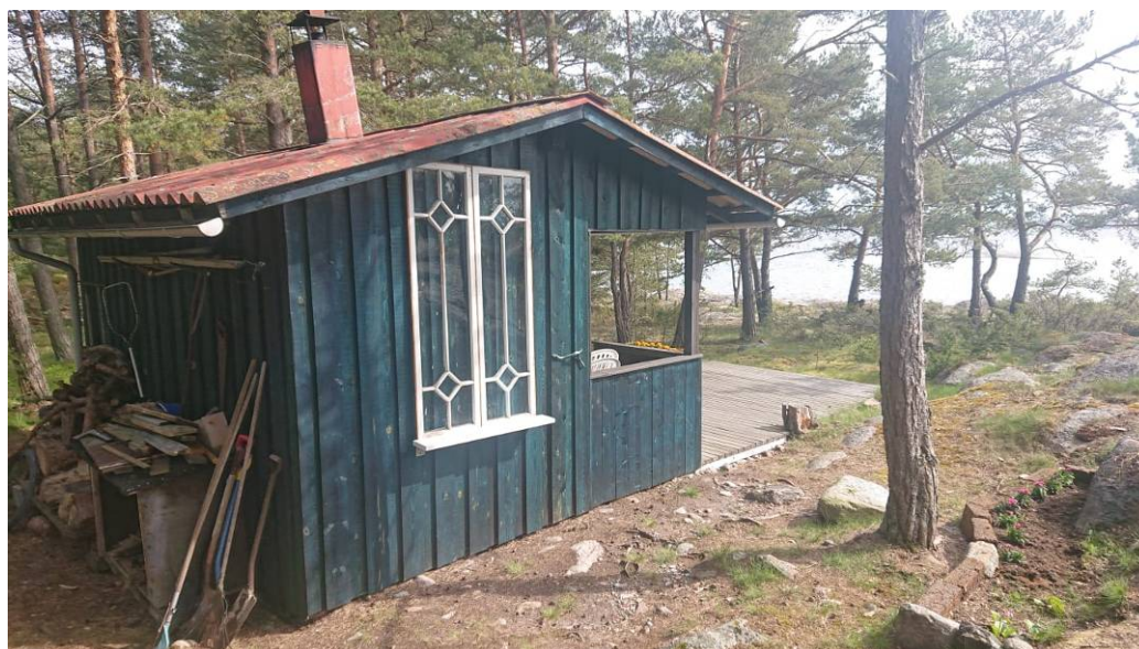
Bild 10. Bastu som är byggd på 1970-talet.
