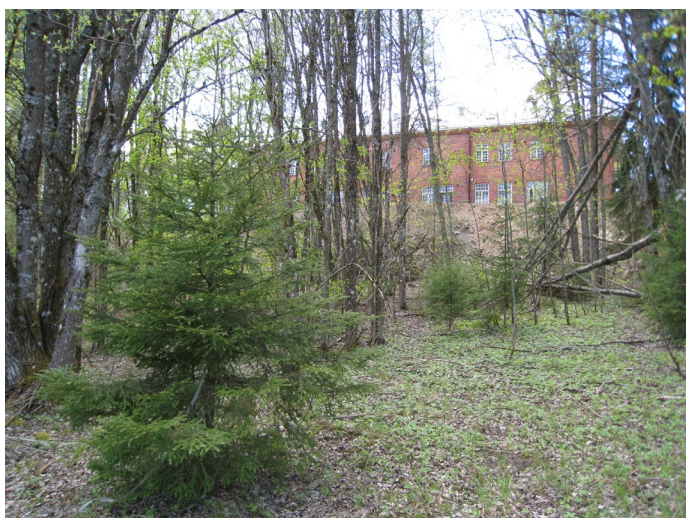
Tegelbyggnaden sett från norr Tiilirakennus pohjoispuolelta katsottuna
