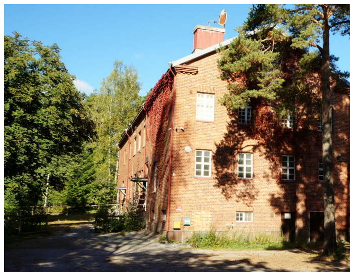
Norrgårds gamla sjukhusbyggnad Norrgårdin vanha sairaalarakennus
