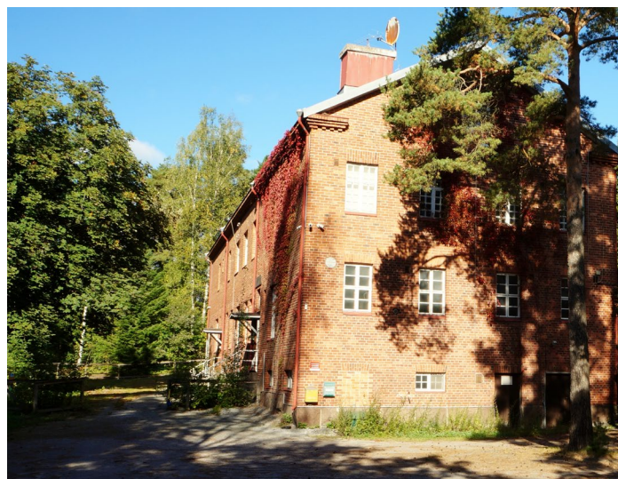
Norrgårds gamla sjukhusbyggnad Norrgårdin vanha sairaalarakennus
