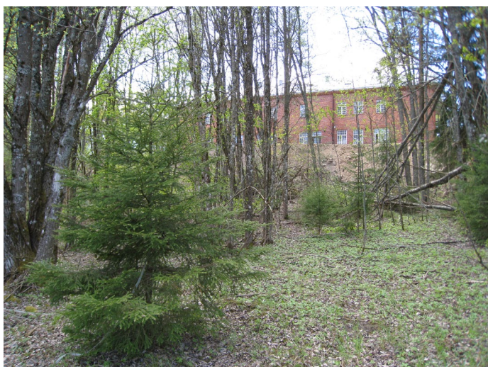
Tegelbyggnaden sett från norr Tiilirakennus pohjoispuolelta katsottuna
