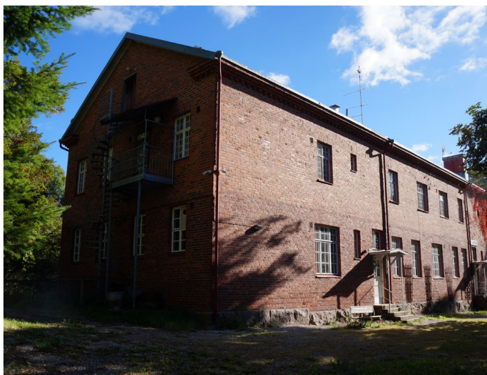
Norrgårds gamla sjukhusbyggnad Norrgårdin vanha sairaalarakennus
