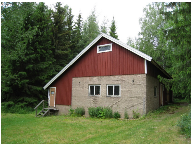
Ekonomibyggnaden på bostadsfastigheten. Asuintilan talousrakennus
