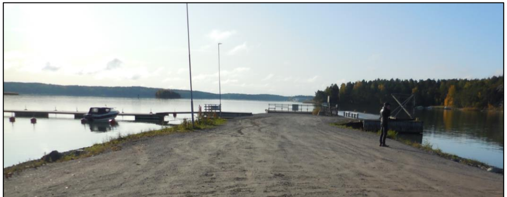
Kuva 9. Vierassataman eteläosan maapenkereellä sijaitsevat laiturirakenteet.
