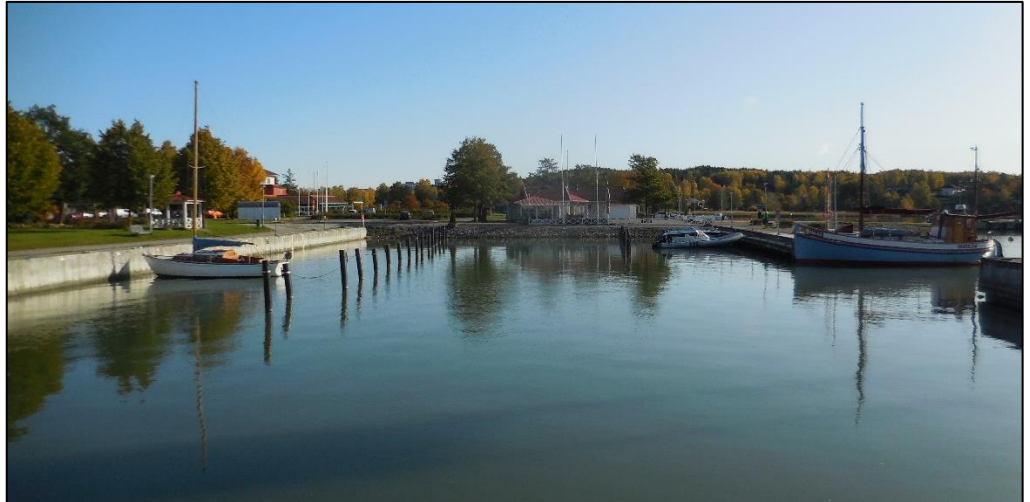
Kuva 8. Satama-altaan paalukiinnityspaikat rantalaiturin ja laituri/puutasanteen yhteydessä. Oikealla näkyy satama-altaan suuaukon kylkikiinnityspaikka.
