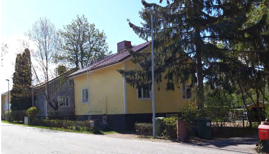
Kuva: Lehmustien varrella on ryhmä hyvin säilyneitä 1950-luvun puolivälin omakotitaloja. Ryhmässä näkyy, miten rakennusten korkeus ja kattokulma madaltuvat kohti 60-lukua. Valokuva: Iina Paasikivi.
