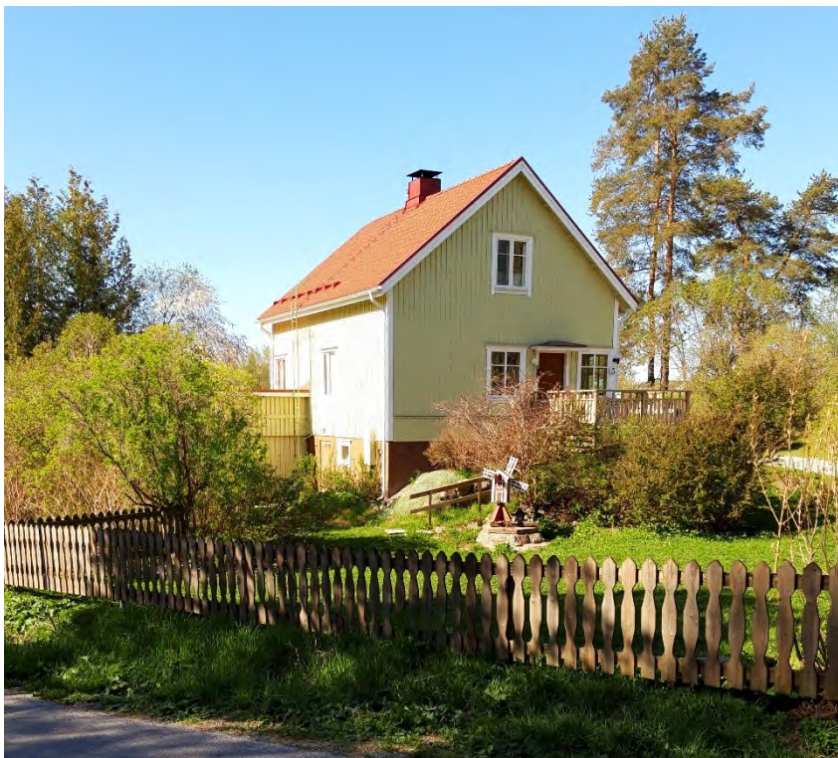
Kuva: Rakennushistoriallisesti arvokkaaksi inventoinnissa luokiteltu omakotitalo myös vuodelta 1947. Alkuperäiset piirteet ovat hyvin säilyneet. Valokuva: Iina Paasikivi.
