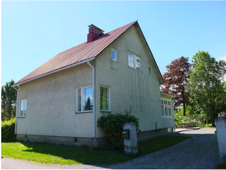
Kuva: Tässä rakennuksessa kulmaikkunoita on molemmissa nurkissa. Kulmaikkuna on ehdottomasti funktionalismin tuoma uusi, moderni yksityiskohta. Kuvan rakennuksessa näkyy paljastavasti se, miten funktionalismin tyylipiirteet siirtyivät jälleenrakennuskauden tavanomaiseen rakentamiseen. Myöhemmin rakennuksia on muutettu "romanttisempaan" ilmeeseen. Valokuva: Teija Mustonen TMK/MIP
