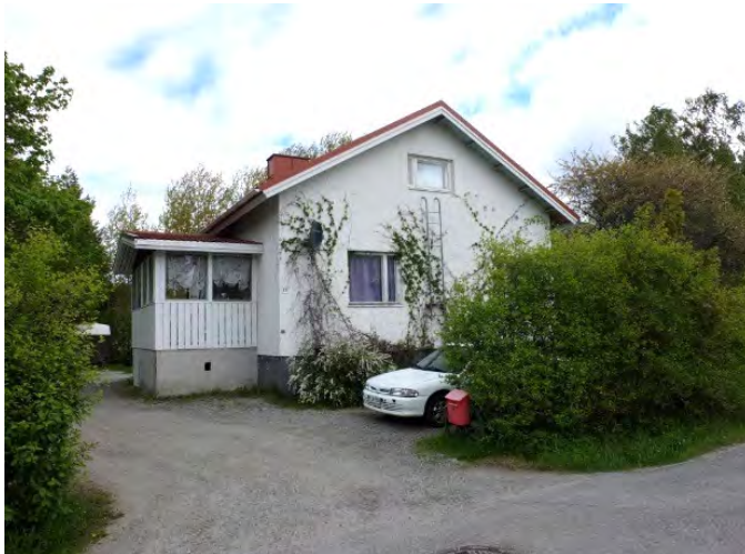
Kuva: 1950-luvun loppupuolen taloissa kattokulma madaltuu ja räystäät pitenevät. Etupiha ja pensasaita kuuluvat asiaan. Kehitys kulkee kohti yksikerroksista talotyyppiä. Yksikerroksiset alueet toteutuivat muualla. Valokuva: Teija Mustonen TMK/MIP.
