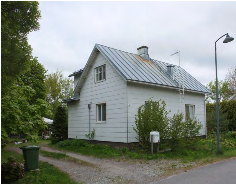
Kuva: Rakennus vuodelta 1948. Paraisilla yleinen Mineritti-levy nähdään usein myöhemmän ajan julkisivumuutoksena. Se voi olla myös alkuperäinen materiaali. Valokuva: Teija Mustonen TMK/MIP
