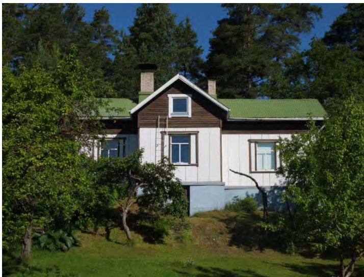
Kuva: Huvilakadun varralla 1923 rakennettu huvila, joka on saanut myöhemmin vuosikymmeninä muodistettut julkisivut. 60-luvun tasakattomuodin vaikutuksesta vanhoja, korkeita rakennuksia uudistettiin verhoilemalla vaalealla levyllä siten, että päätökolmio verhoiltiin tummalla laudalla. Tässä ikkunoitten vanhanaikaista, pystyä vaikutelmaa on vielä haluttu muuttaa listoituksin.
