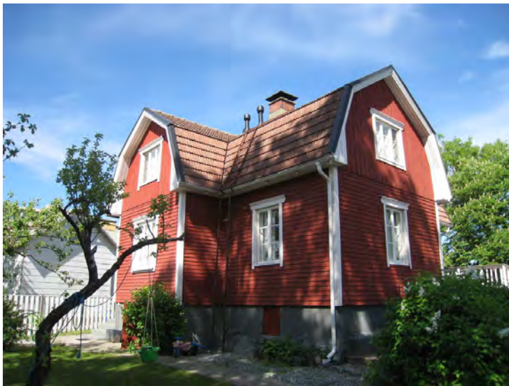
Kuvat: Nilsdorffinkadun varren vanhoja rakennuksia on vuosisadan kuluessa korjattu moneen kertaan. Valokuvat: Teija Mustonen, TMK/MIP
