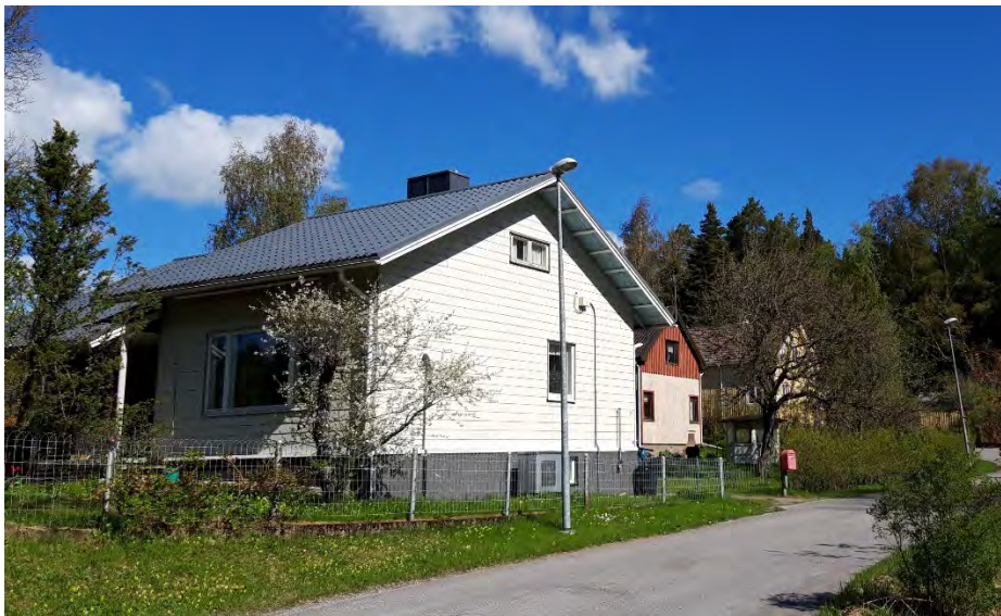
Kuva: Vuonna 1964 rakennettu omakotitalo on 1-kerroksinen, kattokulma edelleen loiventunut. Julkisivumateriaalina on asbestisementtilevy. Taustalla näkyy 40-luvun rakennus, jonka julkisivut on modernisoitu 70-luvulla ominaiseen tyyliin Karaatti-levyllä. Rakennuksen korkea pääty verhoiltiin tummalla laudalla horisontaalisen vaikutelman vahvistamiseksi. Valokuva: Iina Paasikivi.
