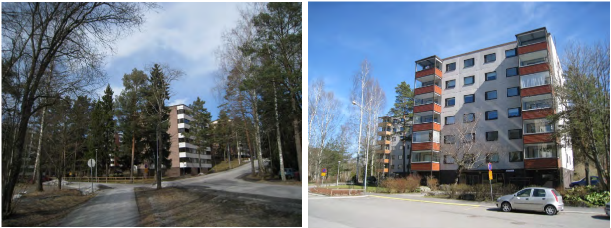
Kuvat: Kerrostalot Tummelitiellä v. 1975 ja Tennbyntien jatkeella v. 1979. Ruutuelementti-tekniikka tuli vallitsevaksi kerrostalojen julkisivun toteutuksessa 70-luvulla. Ikkunanauhat saatiin vielä ”piirtää” elementtipintaan, mutta vähitellen ruutujulkisivu tuli vallitsevaksi. Valokuvat: Laura Ruohonen TMK/MIP.
