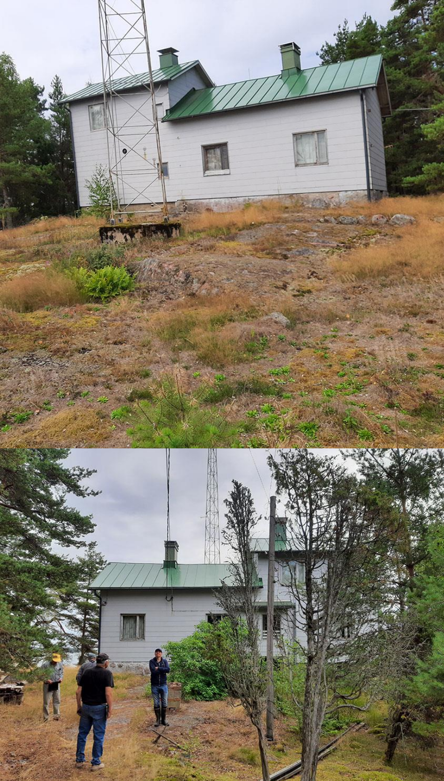
Kuvat 2-3. Luotsiaseman asemarakennus kuvattuna idästä (yläkuva) ja lännestä. Rakennus on laajennuksen ajoilta alkuperäisessä kunnossa kalusteineen. Matalampi osa on vuodelta 1898 ja kaksikerroksinen laajennusosa 1950-luvulta. Rakennuksen itäpuolella on käytöstä poistettu puhelinliikennöintimasto, joka jossain vaiheessa purettaneen turvallisuussyistä. Länsipuolella vanha puhelin- tai sähköpylväs muistuttaa menneiden aikojen teknisistä menestystarinoista. Museoviraston teettämän selvityksen mukaan Timmerholman rakennuskulttuurihistoriallinen merkitys on vähäinen. Rakennuksen koko on 120 m 2 .
