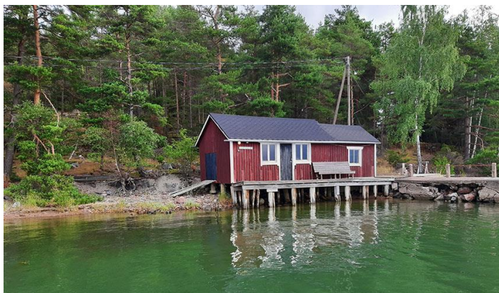
Kuva 1. Luotsiaseman satamalaiturin kohdalla olevassa rantavajassa säilytettiin venekaluston ym. tarvikkeita. Rakennuksen koko on 45 m 2 .
