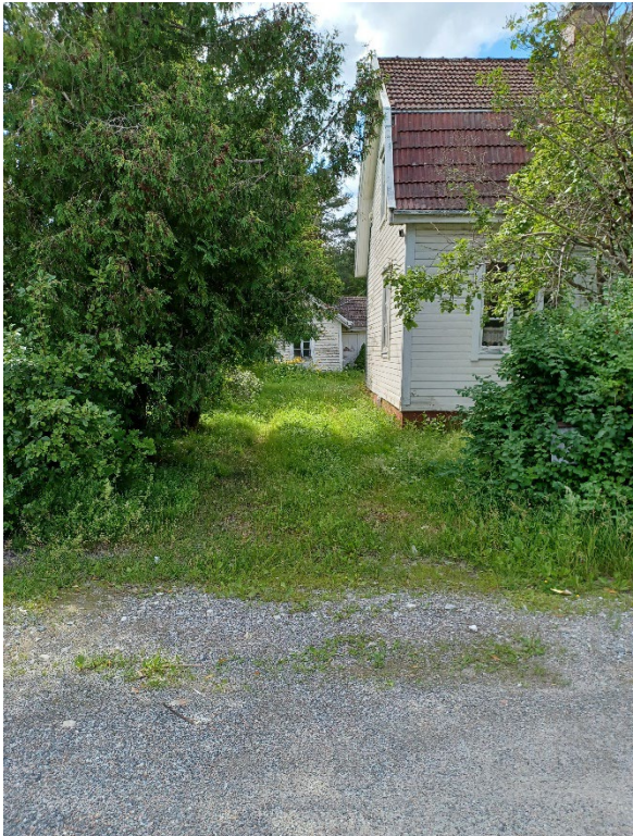
Huvudbyggnaden på fastigheten Fageräng 3:18. Kiinteistöllä Fageräng 3:18 oleva päärakennus.
