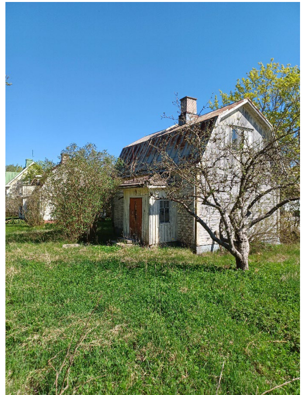
Den förfallna huvudbyggnaden på fastigheten Solhem 3:17. Ränsistynyt päärakennus kiinteistöllä Solhem 3:17.
