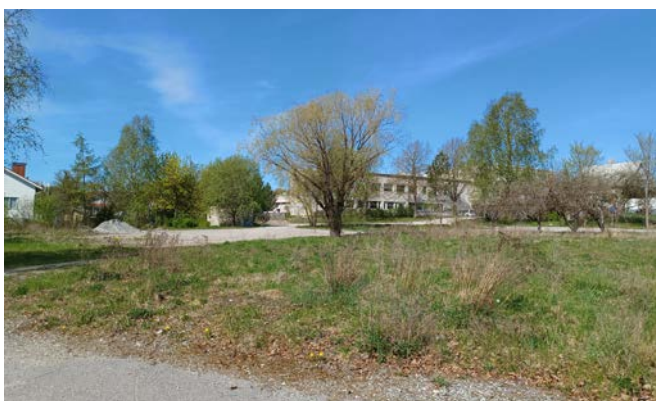
Cirkulationsplatsens närområde där flera byggnader har rivits Kiertoliittymän lähialue, josta on purettu useita rakennuksia
